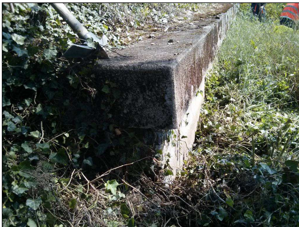
Obr. č. 4 - detailní pohled na římsu nadezdívky v jižní části propustku.
