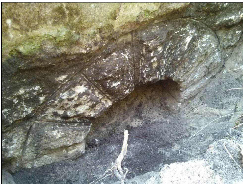
Obr. č. 3 - pohled na klenbovou nosnou konstrukci propustku odhalenou v severní části - zdivo kamenné (pískovce) pojené maltou.
