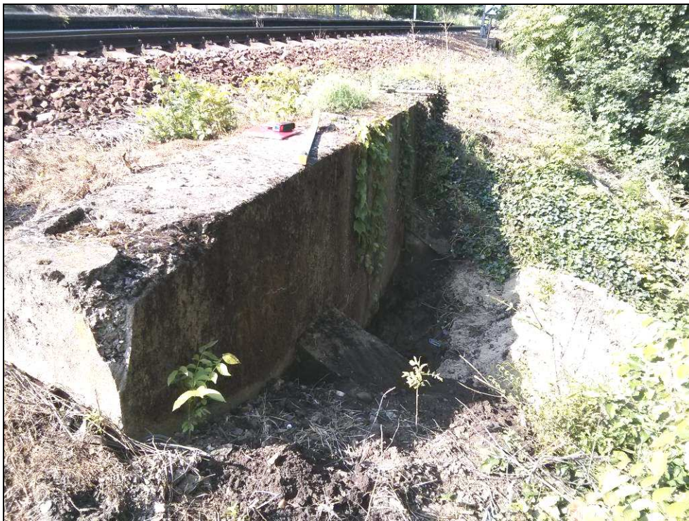
Obr. č. 1 - pohled na severní portál propustku. Fotografie zachycuje nadezdívku propustku, která vyčnívá nad povrch terénu.
